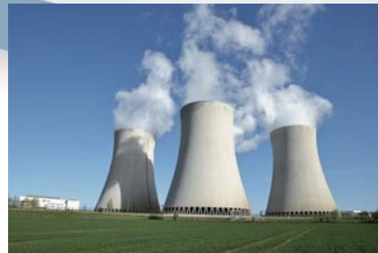
原子力発電所
